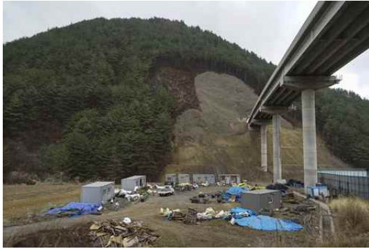
사진. 국도31호선 확포장(태백 동점~봉화 현동) 공사 현장
