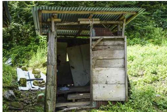
사진. 무궁 스님 집 화장실
